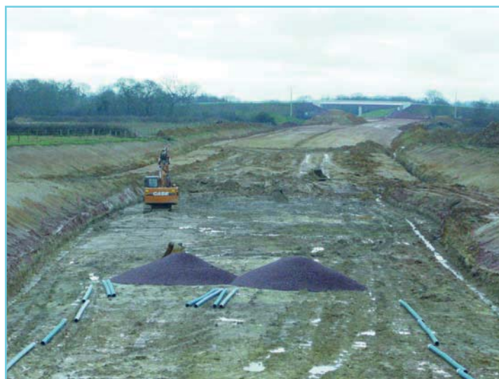
Travaux de la RN174, à Saint-Jean-de-Daye
